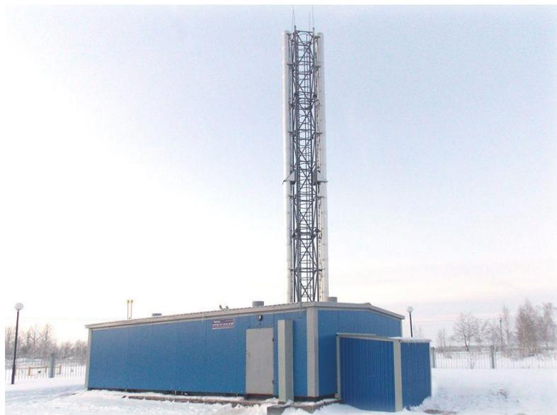
Блочная котельная установка КБТа предназначена для организации горячего водоснабжения и теплоснабжения жилых зданий и сооружений различного назначения больших площадей – от 5000 до 200 000 кв.м. Её работа осуществляется в автоматическом режиме с полным контролем отпускаемого тепла, потребляемой электроэнергии и газа. Работа установки не требует присутствия и контроля со стороны обслуживающего персонала.
