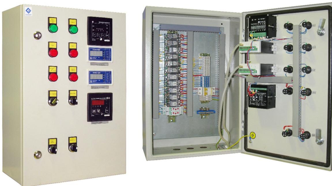
, предназначен для управления работой паровых одnogорелочных котлов, с рабочим давлением до 0,7 кПа и температурой пара до 150 °С.
